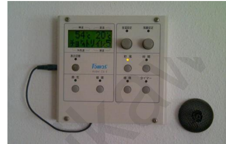
OMソーラ制御盤から データを取り出す
